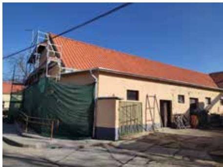
A foktői ABC felújítás alatt
